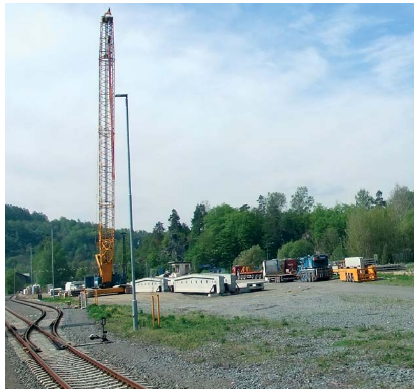
Překládka betonových dílců v Rudě nad Moravou
