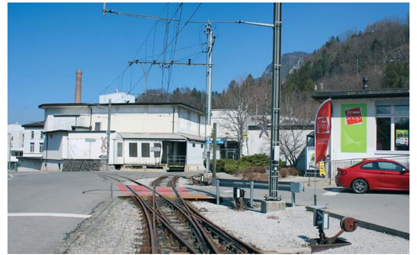
Vlečka čokoládovny v obci Broc
