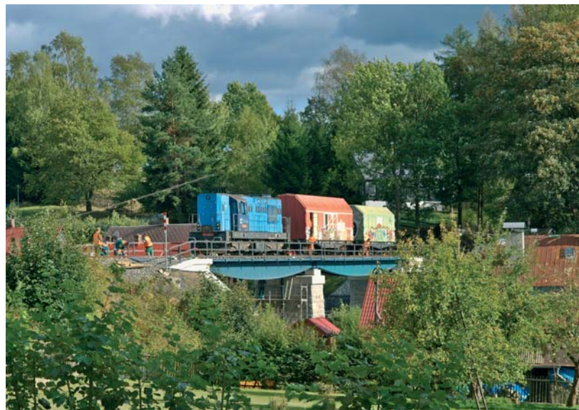
Lokomotiva 742.394 při zátěžové zkoušce nové mostovky v Brtníkách – 25. září 2018
