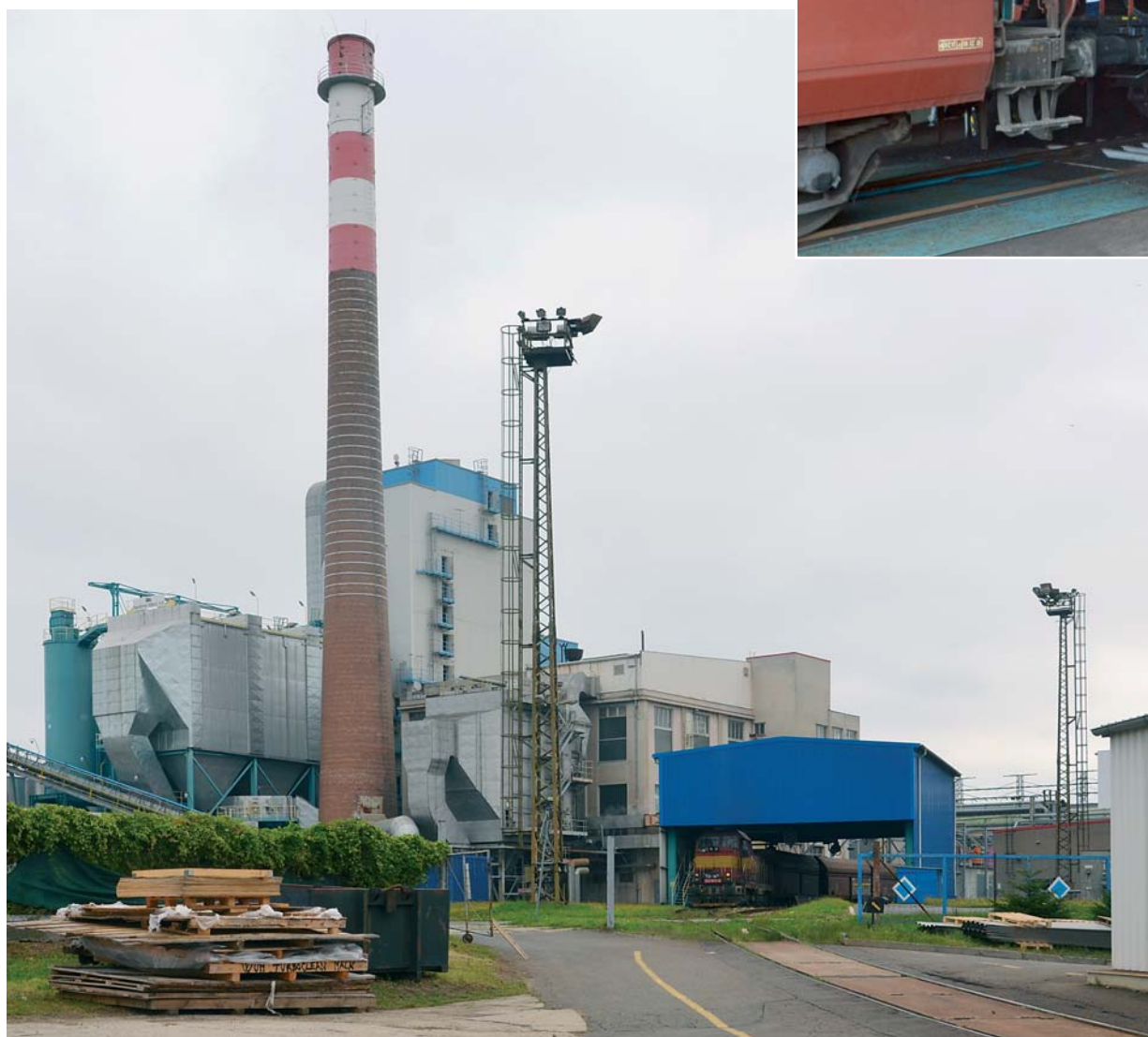
Celkový pohled na teplárnu Tábor včetně vykládací koleje
