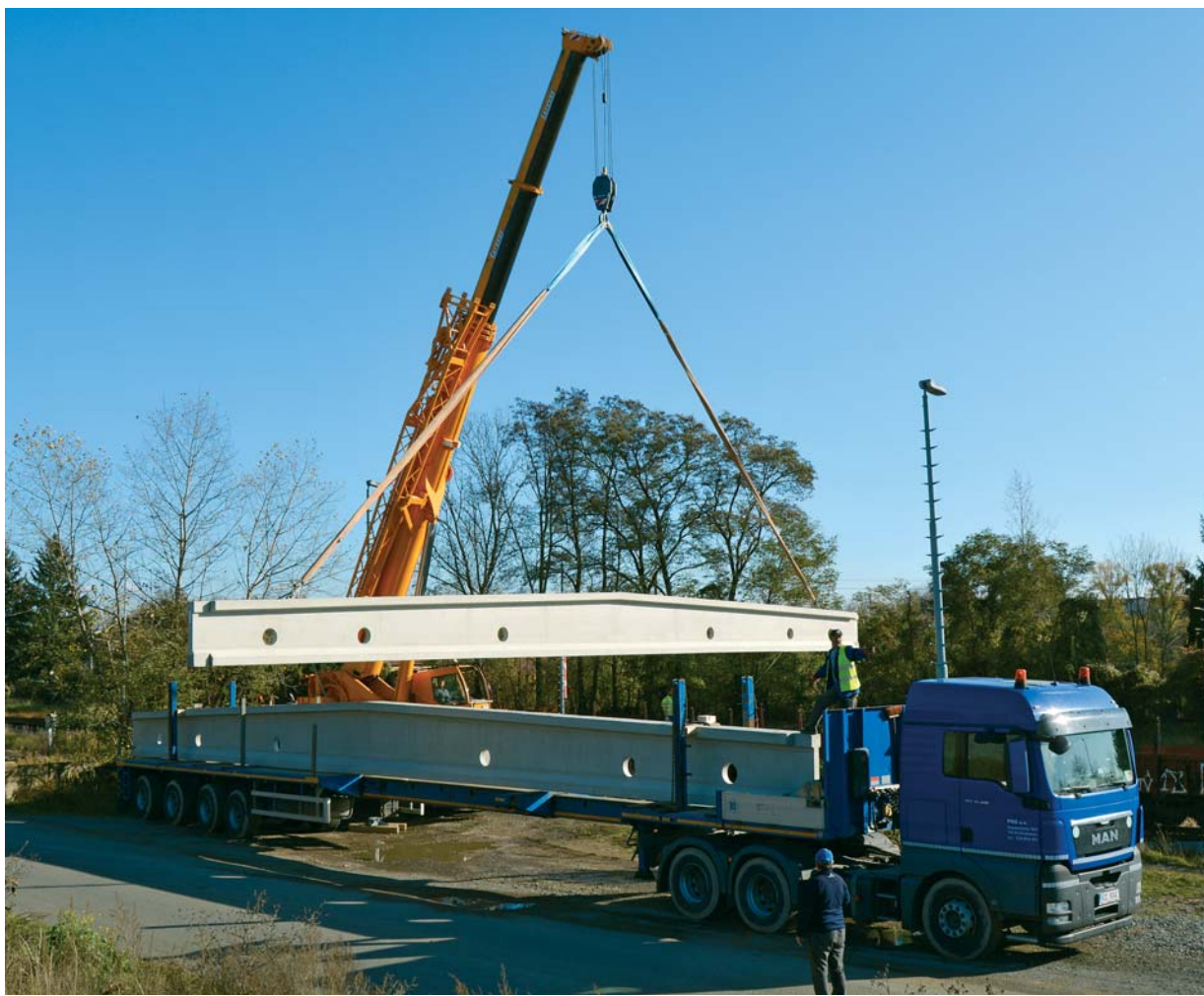
Překládka betonových dílů v železniční stanici Nučice
