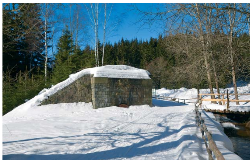
Pilíře mostu přes Moldavský potok
