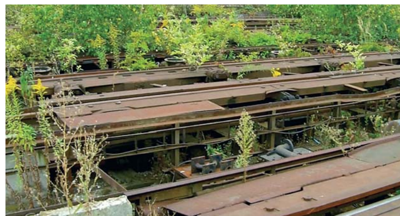
Zarůstající kolejové brzdy
