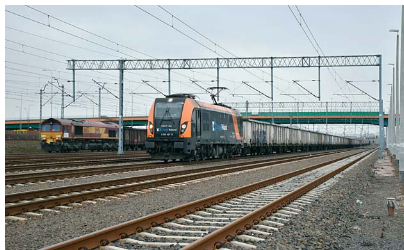
Stanice Warszawa Okęcie je přípojnou stanicí pro vlečku teplárny Siekierki.
