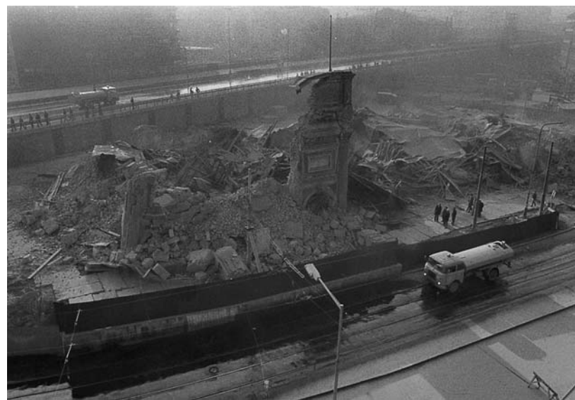
Odstřel výpravní budovy stanice Praha-Těšnov 16. března 1985
