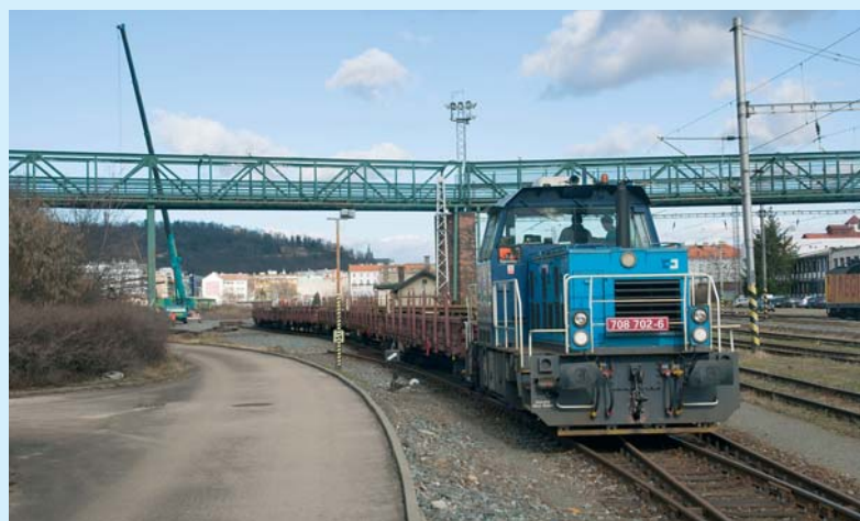
Vykládka tramvajových kolejnic na Smíchově dne 18. února 2020
