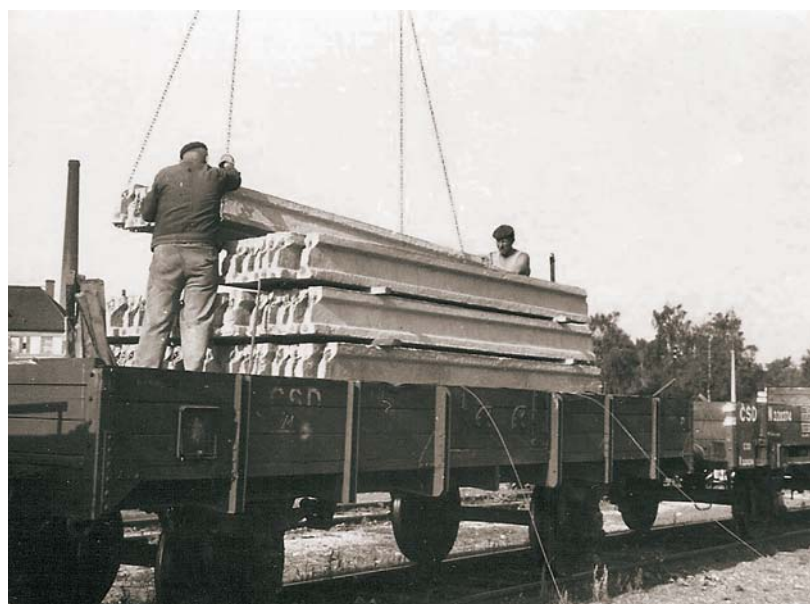
Nakládka betonových prefabrikátů na vlečce Prefa v Přešticích
