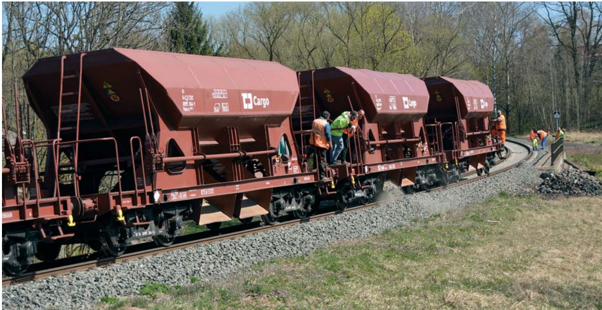
Sypání šterku musí probíhat přesně podle pokynů stavbařů – Pilníkův.
