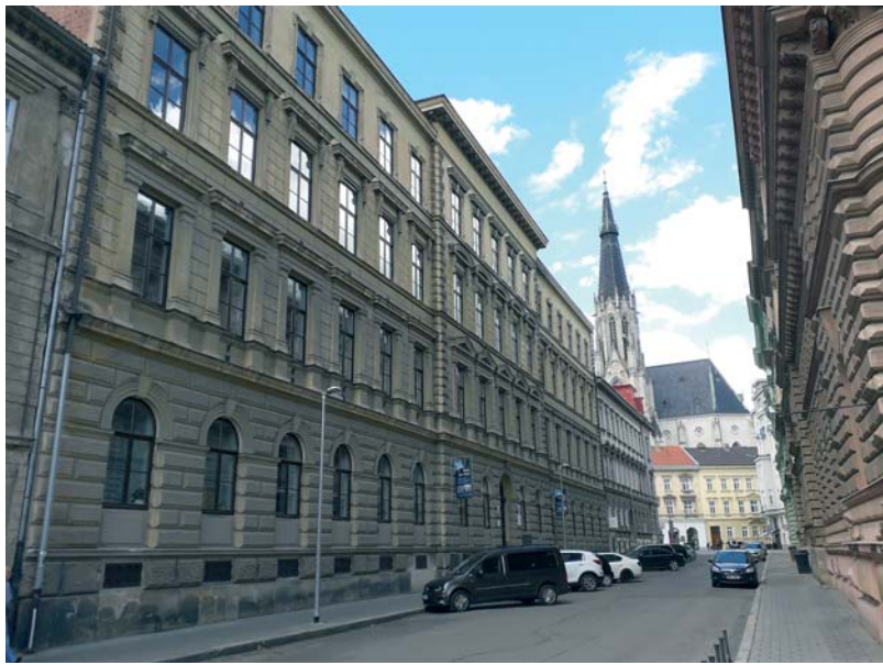
Hlavní budova školy
