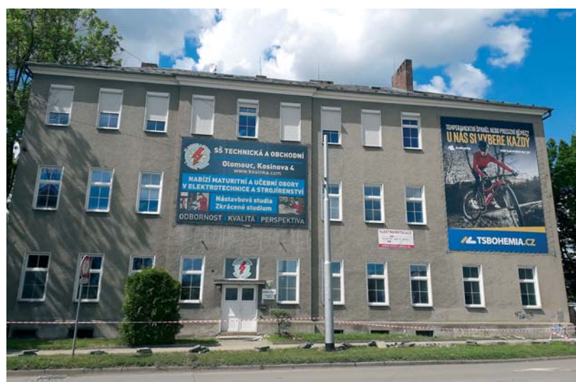
Budova, ve které je probíhá odborný výcvik.
