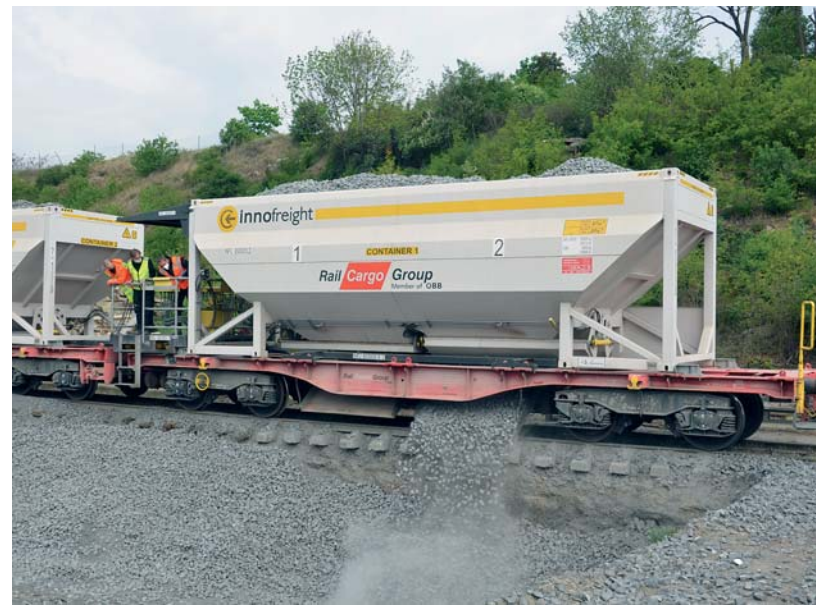
Zkušební vykládka kameniva z RockTaineru INFRA v Praze-Vršovicích Foto: Michal Roh
