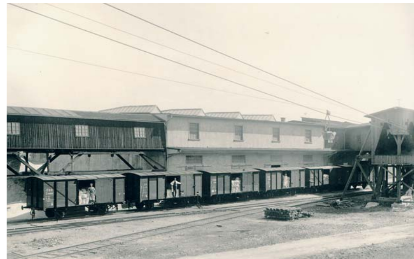
Nákladka upraveného kaolinu na nákladišti u dolu Excelsior. Na snímku je dobře vidět i lanová dráha sloužící k přísunu vytěžené suroviny.
