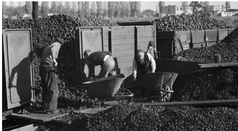
Vykládka uhlí z vysokostěnných vozů byla v minulosti fyzicky velice náročná.
