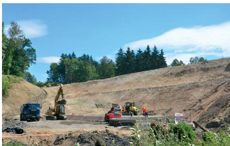
Stavební práce na náspu u Dalovic jsou v plném proudu a snad se vše podaří do konce roku 2020 dokončit. Foto: Michal Roh
