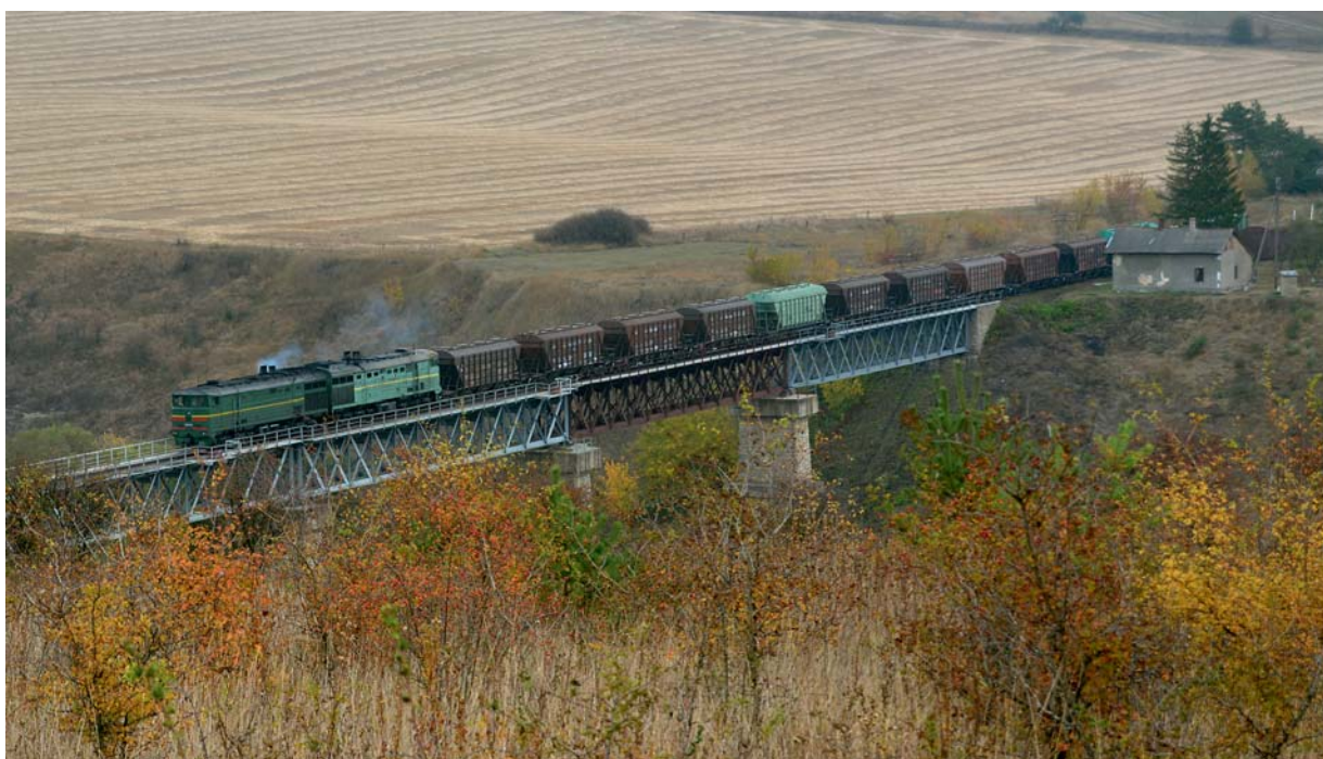
Nákladní vlak sestavený z vozů na jednu z nejnámějších ukrajinských komodit, tedy na obiloviny, projíždí po viaduktu u vsi Žilinci na místní dráze Ivane Puste – Vynhanka (28. září 2019).
