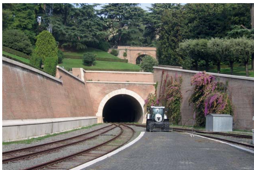
Vjezd tunelem na stanici ve Vatikánu
