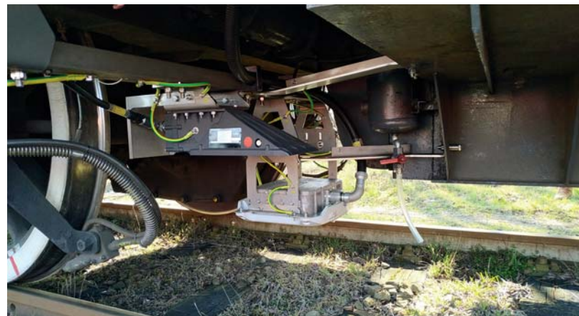
Nainstalovaná konzole s prvky ETCS se snímači a Dopplerovým radarem
