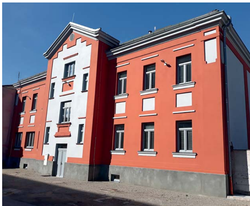
Zrekonstruovaný objekt provozní budovy v OKV Břeclav
