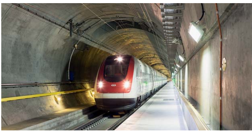
Vysokorychlostní vlak švýcarských železnic v bezpečnostní stanici Sedrun v Gotthardském úpatním tunelu
