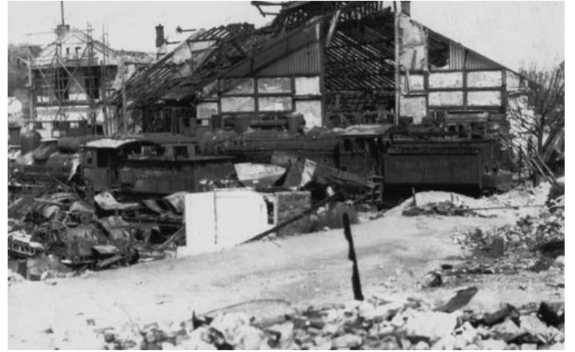
O tom, že železnice na poskytování přepravních služeb armádě často dopltila, svědčí fotografie karlovarské výtopny zničené při spojeneckém náletu v dubnu 1945. Mohlo toto zbytečné ničení výrazněji uspišit konec války?
