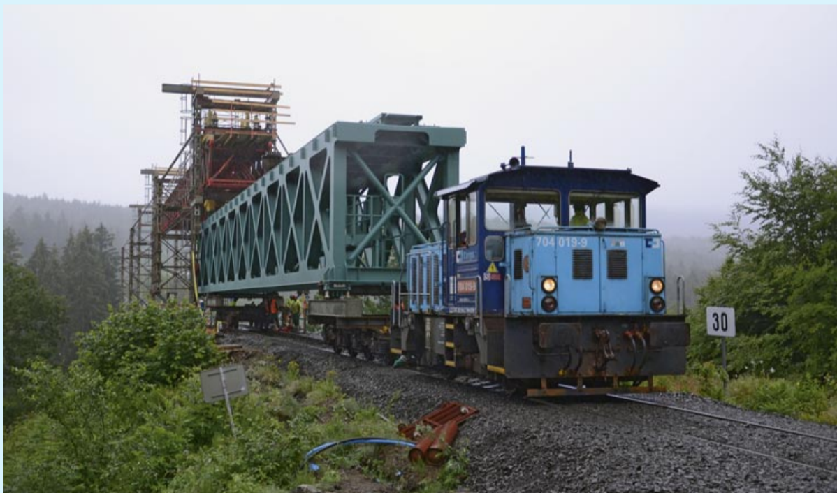
Nasouvání části nové mostní konstrukce lokomotivou ČD Cargo ve Vilémově u Šluknova.
