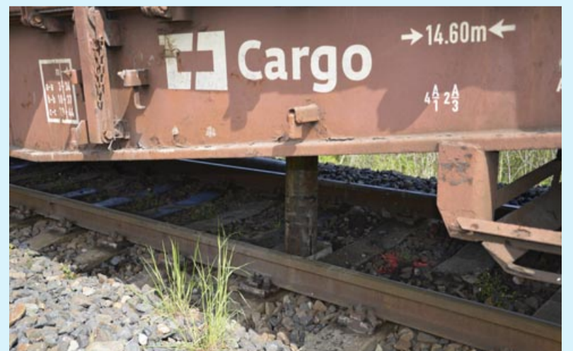
Detail vrtu prováděného přímo z železničního vozu
