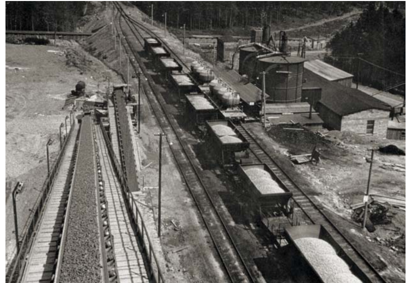
Výstavba přehradní hráze Orlík – pohled na výkladiště Přehrada zaplněné nákladními vozy Sbírká: Michal Roh
