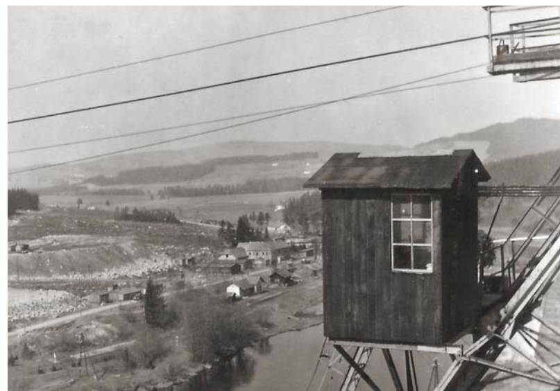
Na stavbě lipenské přehrady byly používány rovněž kabelové jeřáby. Z jednoho z nich byl pořízený snímek, na kterém je dole vidět i původní stanice Lipno nad Vltavou. Foto: Radko Košťál, sbírka Michal Roh
