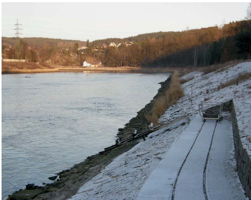
Úzkorozchodná drážka sloužící k přepravě malých plavidel okolo přehradní hráze Kamýk. Na konci drážky, u zařízení sloužícího ke spuštění lodí zpět na vodu je odstaven přepravní vozík – leden 2009. Foto: Michal Roh
