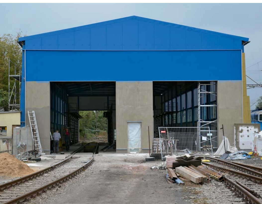
Do konce roku 2021 by měla být dokončena modernizace haly těžké údržby.
