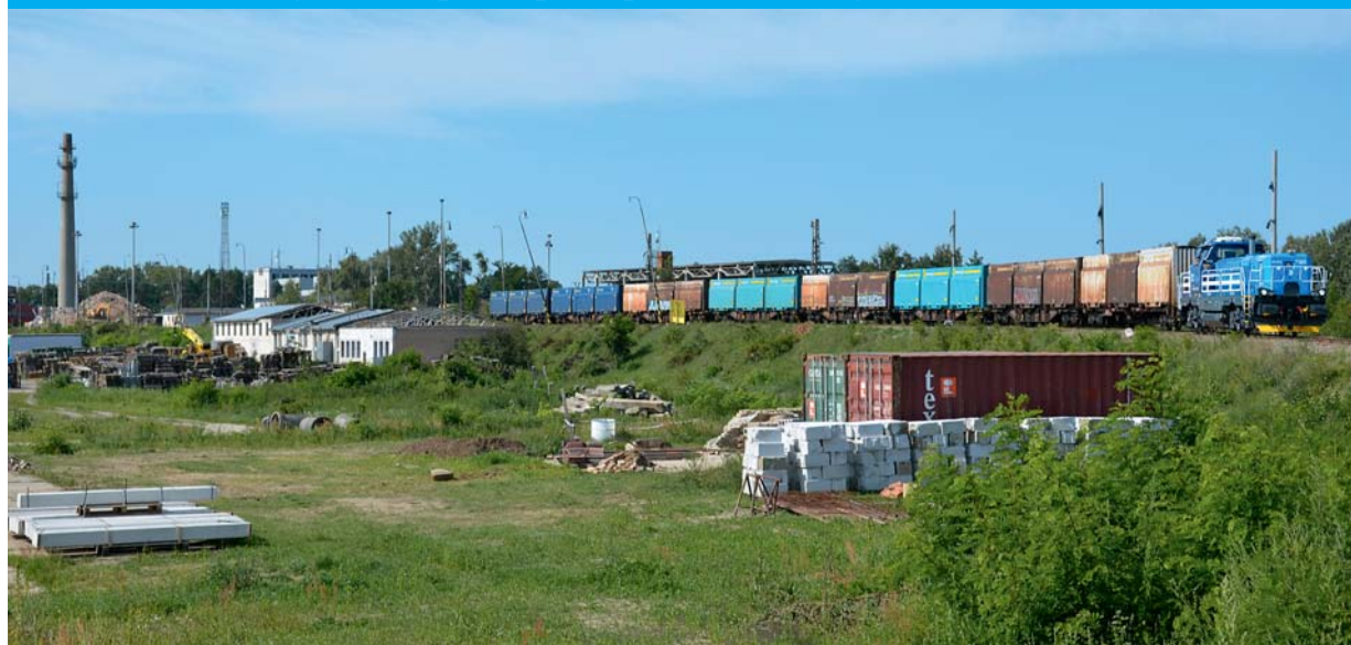
Přistavba skupiny vozů s nástavbami Innofreight na vlečku Dolu Mír
