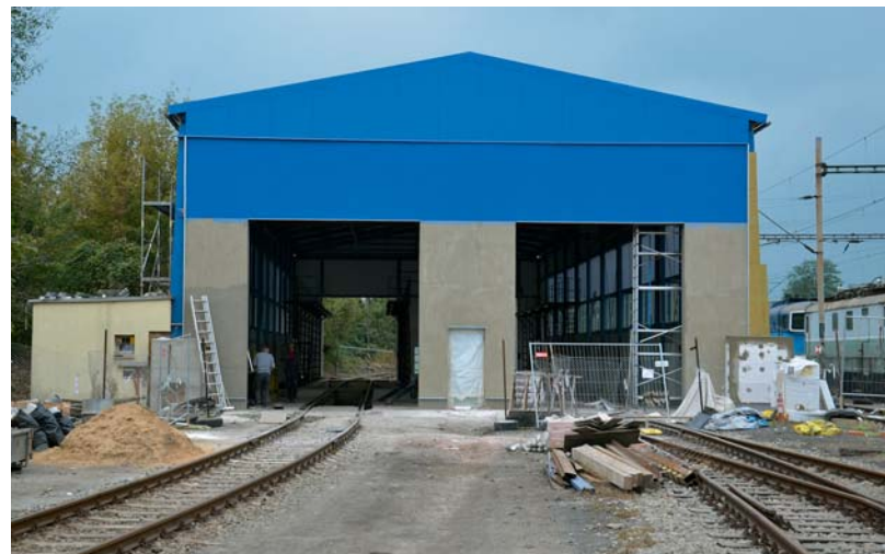
Práce na modernizaci haly těžké údržby byly v říjnu 2021 v plném proudu.
