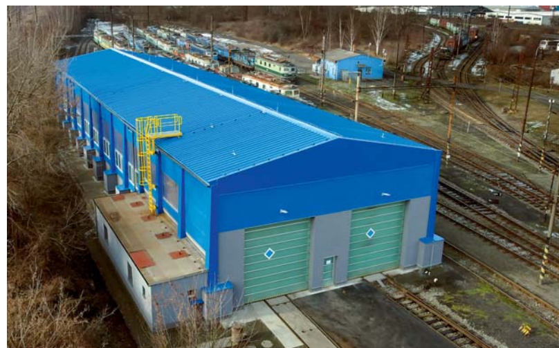
Celkový pohled na halu těžké údržby v SOKV Ústí nad Labem
