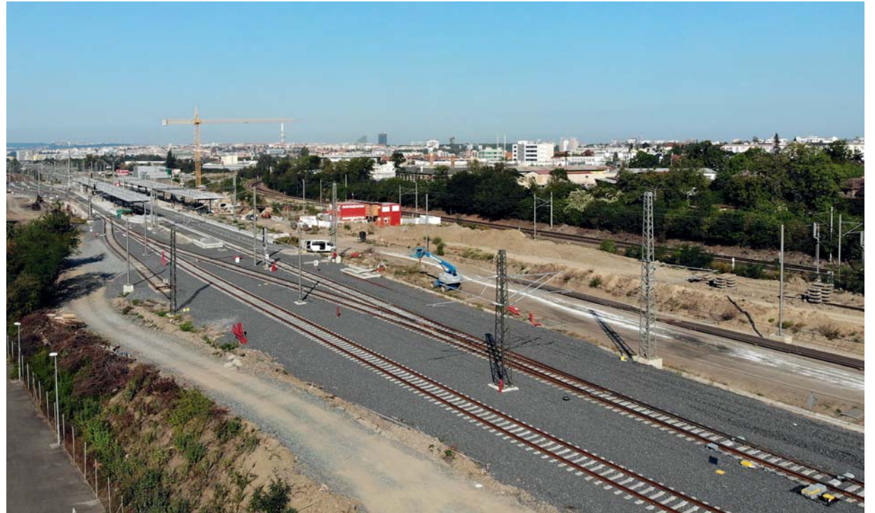
Provoz v pražském uzlu v roce 2021 výrazně ovlivňovaly stavební práce. Z nejvýznamnějších akcí můžeme jmenovat dokončování nové tratě přes zastávky Eden a Zahradní Město.
