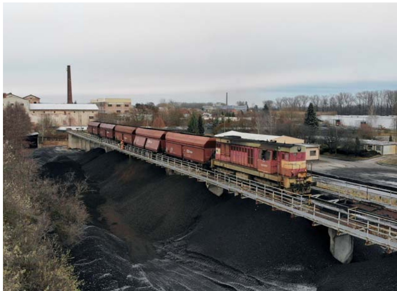
Vykládka uhlí probíhá v teplárně Černožice na vykládacím mostě. V České republice se jedná o ojedinělou technologii. Foto: Michal Roh
