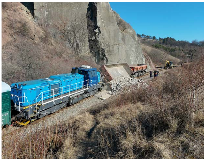
Vykládka kameniva na širé trati před výhybnou Praha-Žvahov
