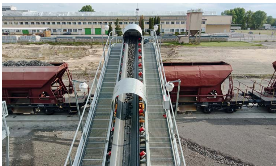
Nakládka štěrku do vozů ČD Cargo ve stanici Malacky
