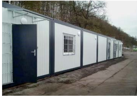
Sociální zázemí v OKV Třinec po rekonstrukci – 7 nových kontejnerů pro sociální zázemí, denní místnost, kancelář, sušárna oděvů a příruční sklad
