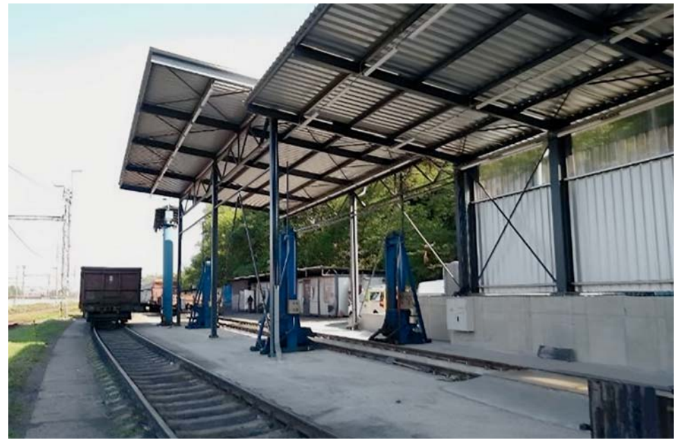
Stejně pracoviště po provedeném zastřešení. Nový je i pracovní kanál.
