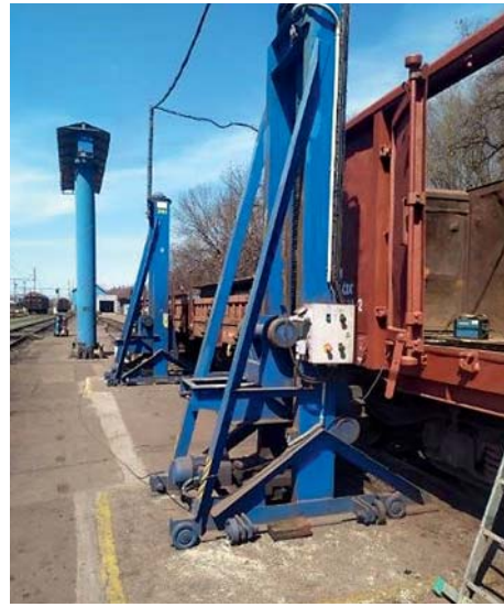
Vyvazovací stanoviště v OKV Třinec před zastřešením opravné koleje č. 12a
