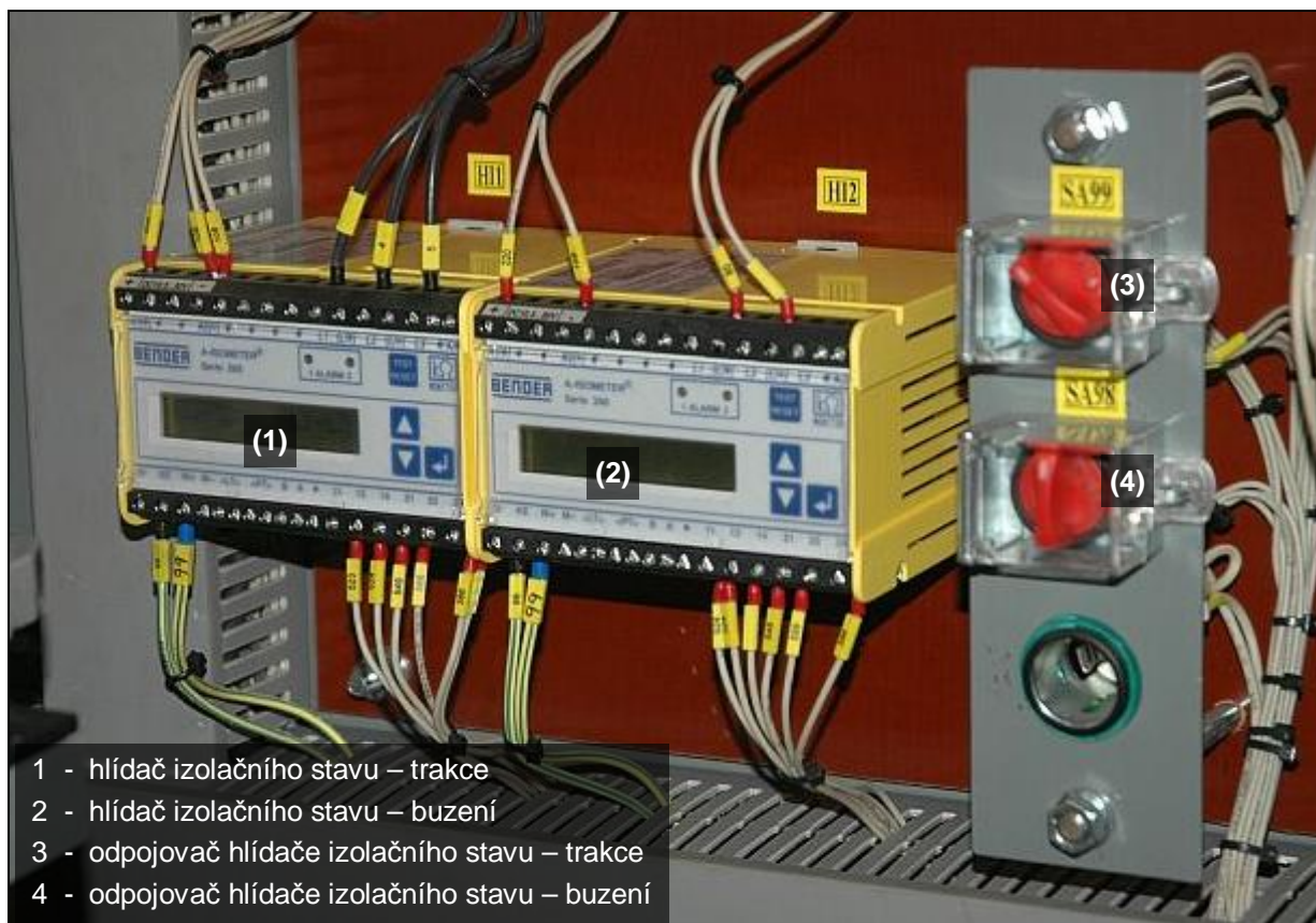
obr. 5: Hlídače izolačního stavu s odpojovači
