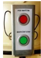
Obrázek: Signální světlo indikace stavu „POD NAPĚTÍM“ a „BEZPEČNÝ STAV“
