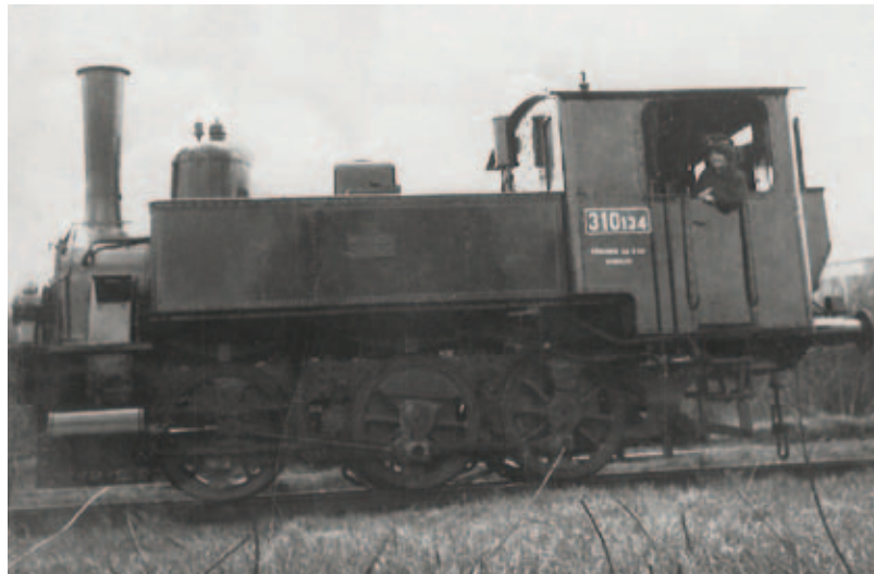
Lokomotiva 310.134 dostala v dílnách v České Lípě generální opravu v roce 1964. Tehdy působila na vlečce cukrovaru v Mnichově Hradišti. Do dopravy vlaků nikdy nezasáhla – neměla kompresor. Na snímku je vidět před kabinou strojvůdce tlumič výfuku parní brzd, kterou byla vystrojena. Fotografie vlevo zachytila i poněkud netradiční prohlídku komína (foto z archivu Zdeňka Hájka)
