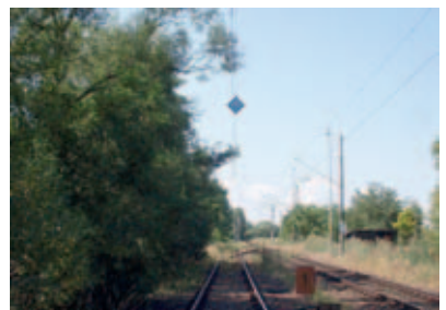
Tak vypadá začátek pomalé jízdy 10 km/h. Za výhybkou na levé straně ve směru jízdy na mě čeká výkolejka, a tak musím jet velmi opatrně, abych ji nepřehlédl
