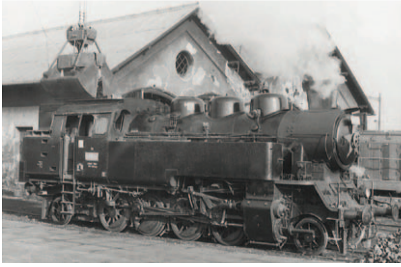
Parní lokomotiva 433.021 při zbrojení jeřábem Kirow v lokomotivním depu Brno dolní. Snímek z archivu Zdeňka Hájky byl pořízen v roce 1979
