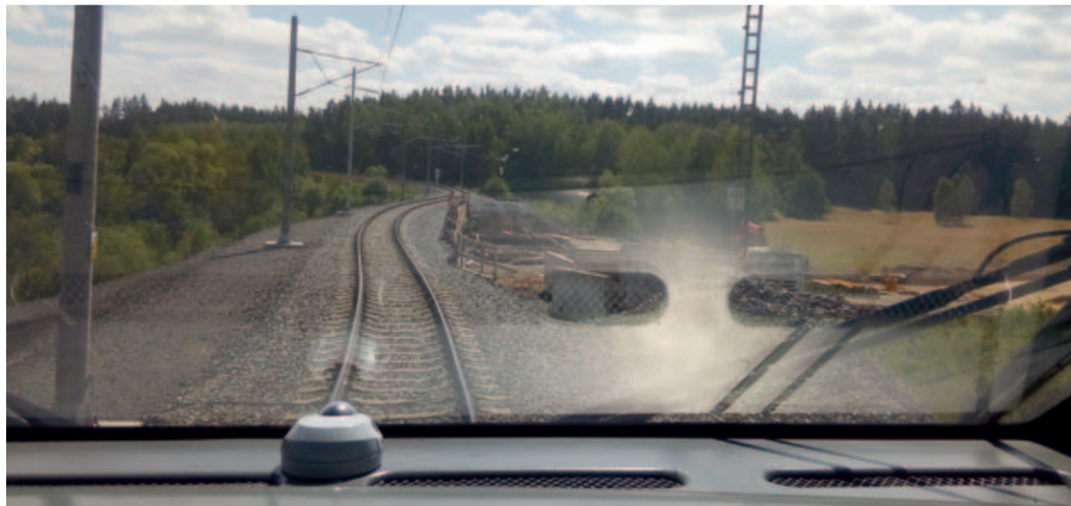
Traťový úsek na trati Plzeň–Cheb, kde 28. července došlo k závažné mimořádné události. Záběr, který velmi dobře zachycuje stav trati a po stranách i ruch na stavbě železničního nadjezdu nad pozemní komunikací, byl kolegou Pavlem Corradiniem pořízen jen několik dní před touto nehodou
