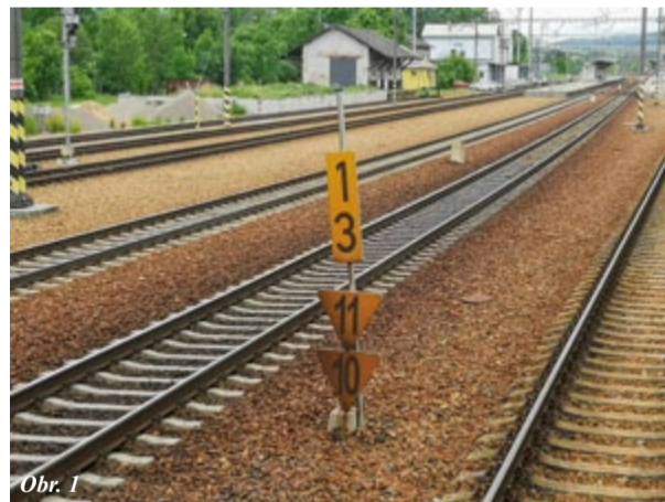
Z obr. 1 je zřejmé, že při nízkém umístění často bývají návěstidla pokryté rzi a prachem od projíždějících vlaků. Při stávající údržbě zanedlouho opticky splnou se šterkovým ložem (foto: Petr Štáštka). Obrázek 2 dokumentuje rychlostníky N a 3 společně se staničnickem vlevo a rychlostník NS vpravo (Chodová Planá). Foto: Jaromír Ott
