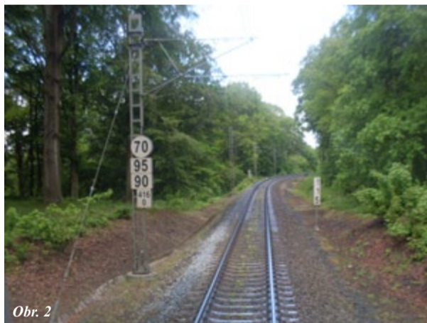
Z obr. 1 je zřejmé, že při nízkém umístění často bývají návěstidla pokryté rzi a prachem od projíždějících vlaků. Při stávající údržbě zanedlouho opticky splnou se šterkovým ložem (foto: Petr Štáštka). Obrázek 2 dokumentuje rychlostníky N a 3 společně se staničnickem vlevo a rychlostník NS vpravo (Chodová Planá). Foto: Jaromír Ott
