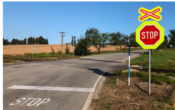
Příkladně provedené dopravní označení, kdy na slavonickém železničním přejezdu P6442 km 38,472 v ulici Rudolecká bylo 18. září tohoto roku osazeno zvýrazněné dopravní značení (A32a + P6) na retroreflexním žlutozeleném fluorescenčním podkladu. Poděkování našich kolegů z Telče tentokrát směřuje na Správu tratí v Jihlavě. Redakce Zájmu strojevedouce samozřejmě ráda zveřejní i další příklady dobré a zejména rychlé spolupráce mezi dopravci a provozovatelem dráhy
