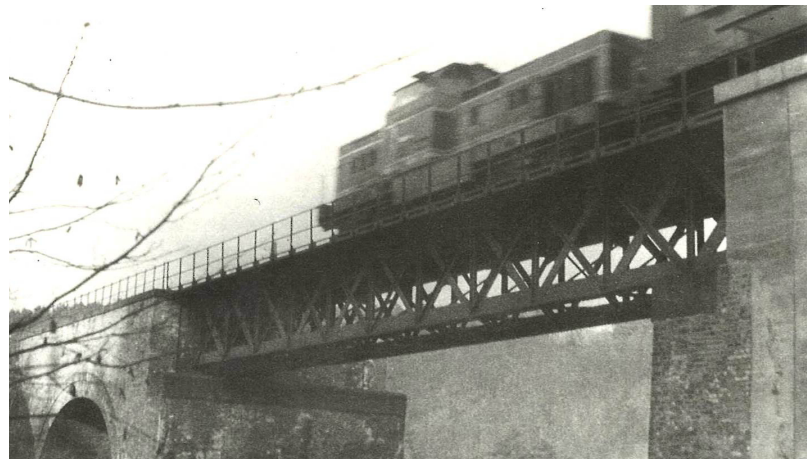
Zv. Železnák – most přes říčku Bobravu a silnici Radostice–Tetčice/Střelice v roce 1967. Délka mostu je 53 m, výška nad hladinou říčky 18,5 m. Os vlaky vozily v té době lok. T444.1 (foto Z. Hájek)
