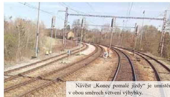
V Chotýčanech je návěst „Začátek pomalé jízdy“ při jízdě proti hrotu umístěn před výhybkou.
