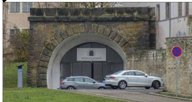
Východní (mělnický) portál litoměřického tunelu.
